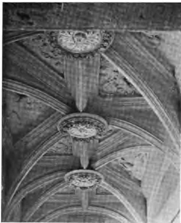
Fig. 158. — Voûte rampante dans l'escalier du château d'Azay-le-Rideau. Prolongement des arcs par des tympans verticaux soutenant des dalles sculptées.
